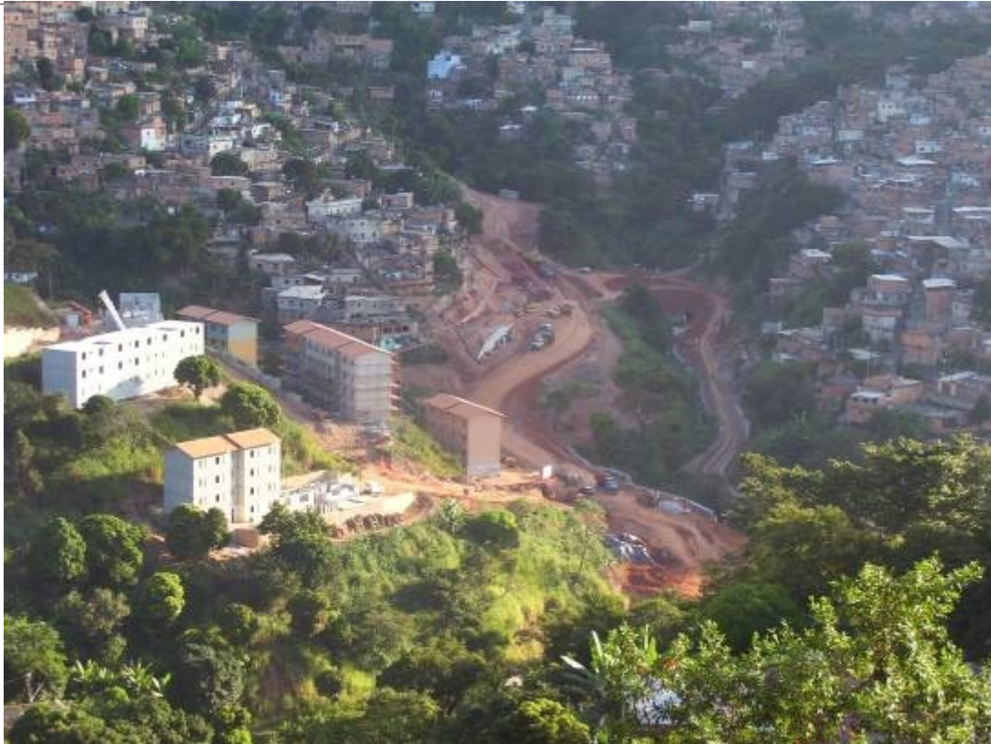
Figura 2: Foto panorâmica das áreas de intervenção urbanísticas e ambientais.
